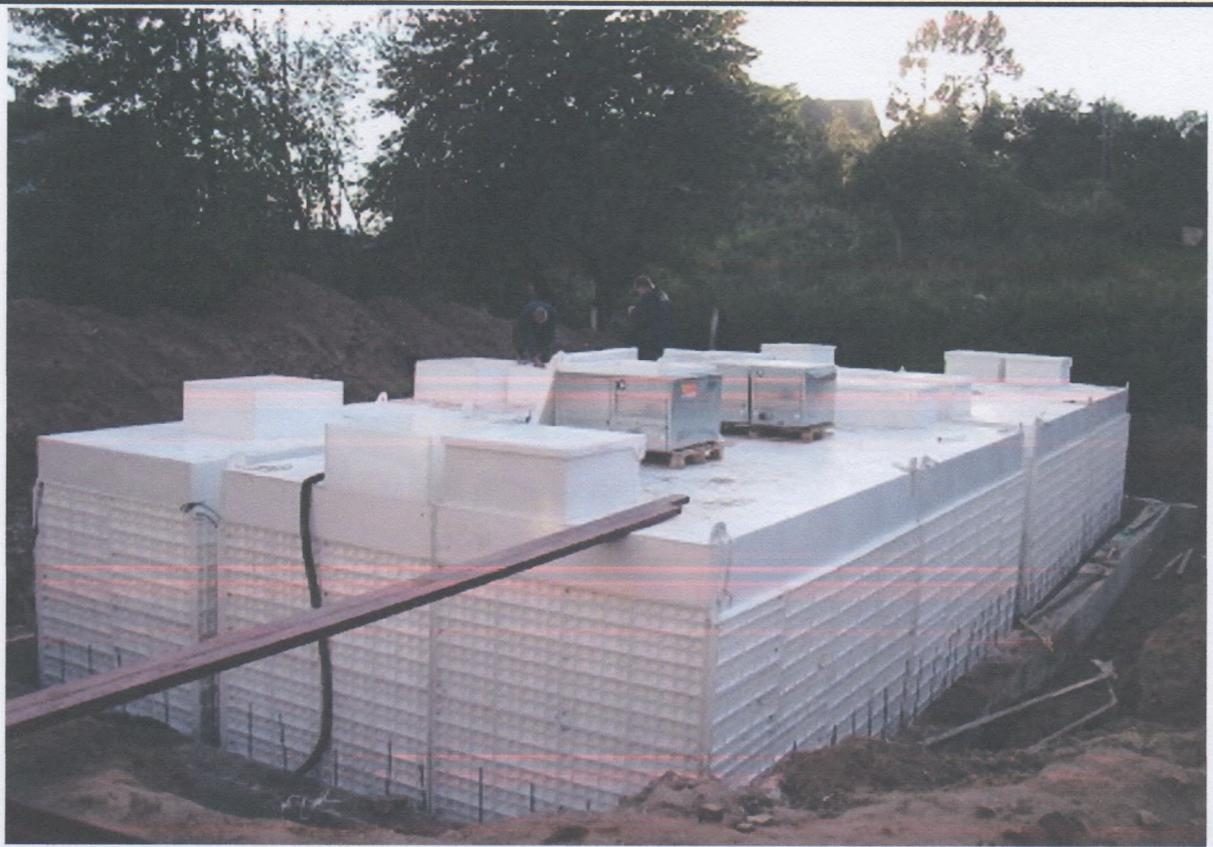
**Рис.12.2. Блочные канализационные очистные станции**
